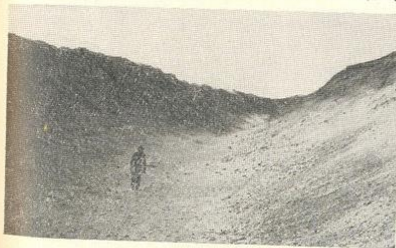
Рис. 27 Участок Каракумского канала, полученный взрывным способом.
