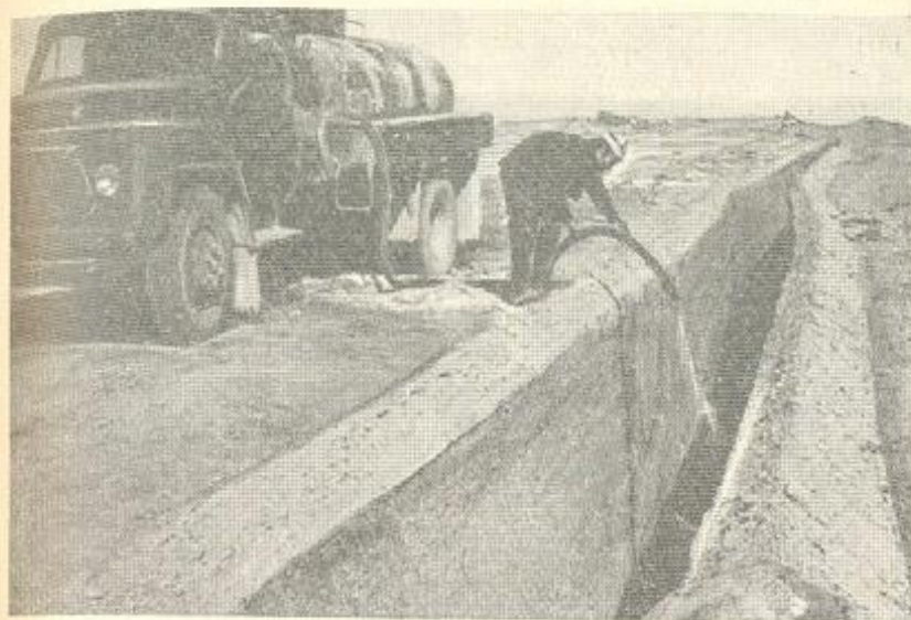
Рис. 5. Получение линейного заряда игданита путем заливки аммиачной селитры дизельным топливом.
