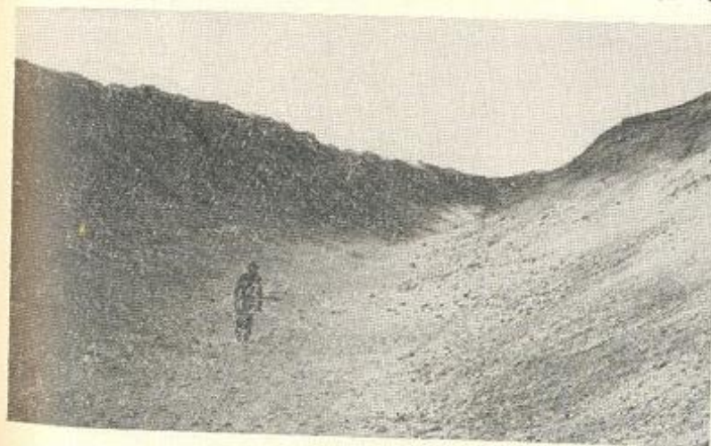
Рис. 27 Участок Каракумского канала, полученный взрывным способом.
