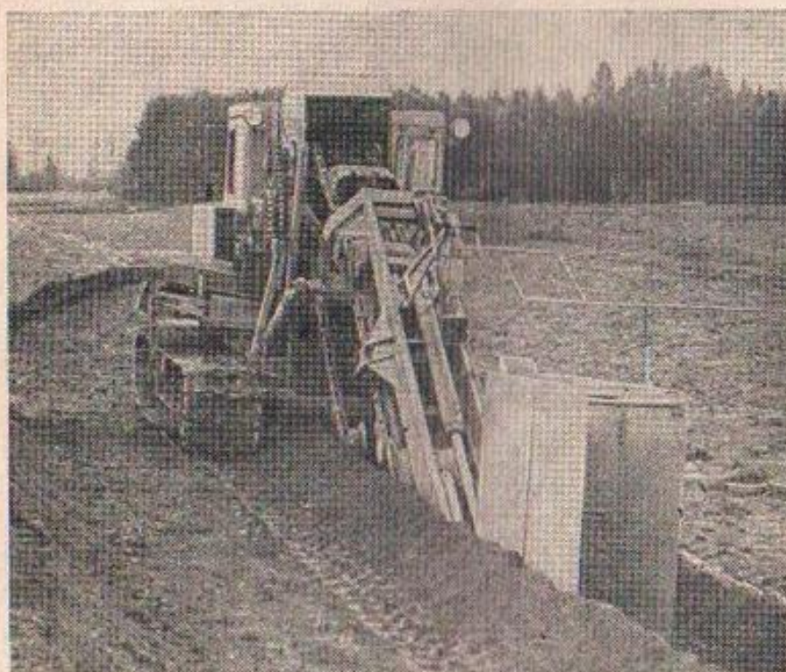
Рис. 26. Экскаватор ЭТЦ-202 в работе.
