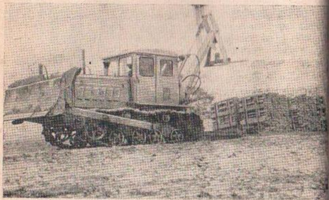
Рис. 21. Развозка труб в контейнерах по трассам.
