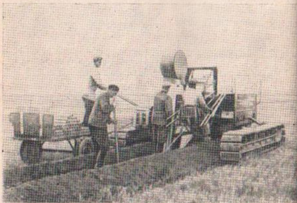
Рис. 19. Транспортировка дренажных материалов на тележке рядом с траншеекопателем.
