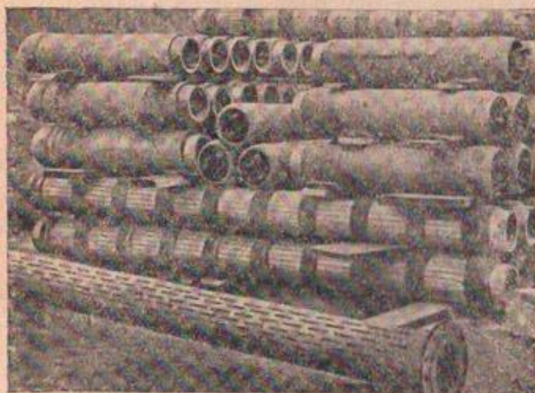
Фиг. 806. Группа щелистых звеньев и отстойников деревянных фильтров
