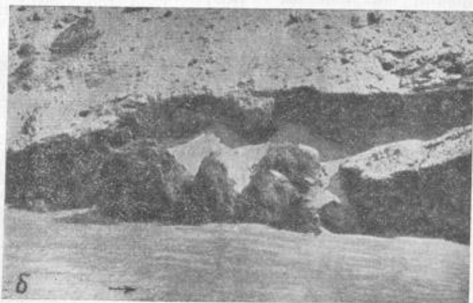
Рис. 1. Местный размыв (дейгиш) берегов Каракумского канала меандрирования (б), и образование осередков, приводящее к общему их несвязности 1 — воронка дейгиша;
