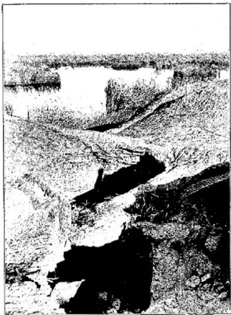
Разрушение берегов сбросными водами.
