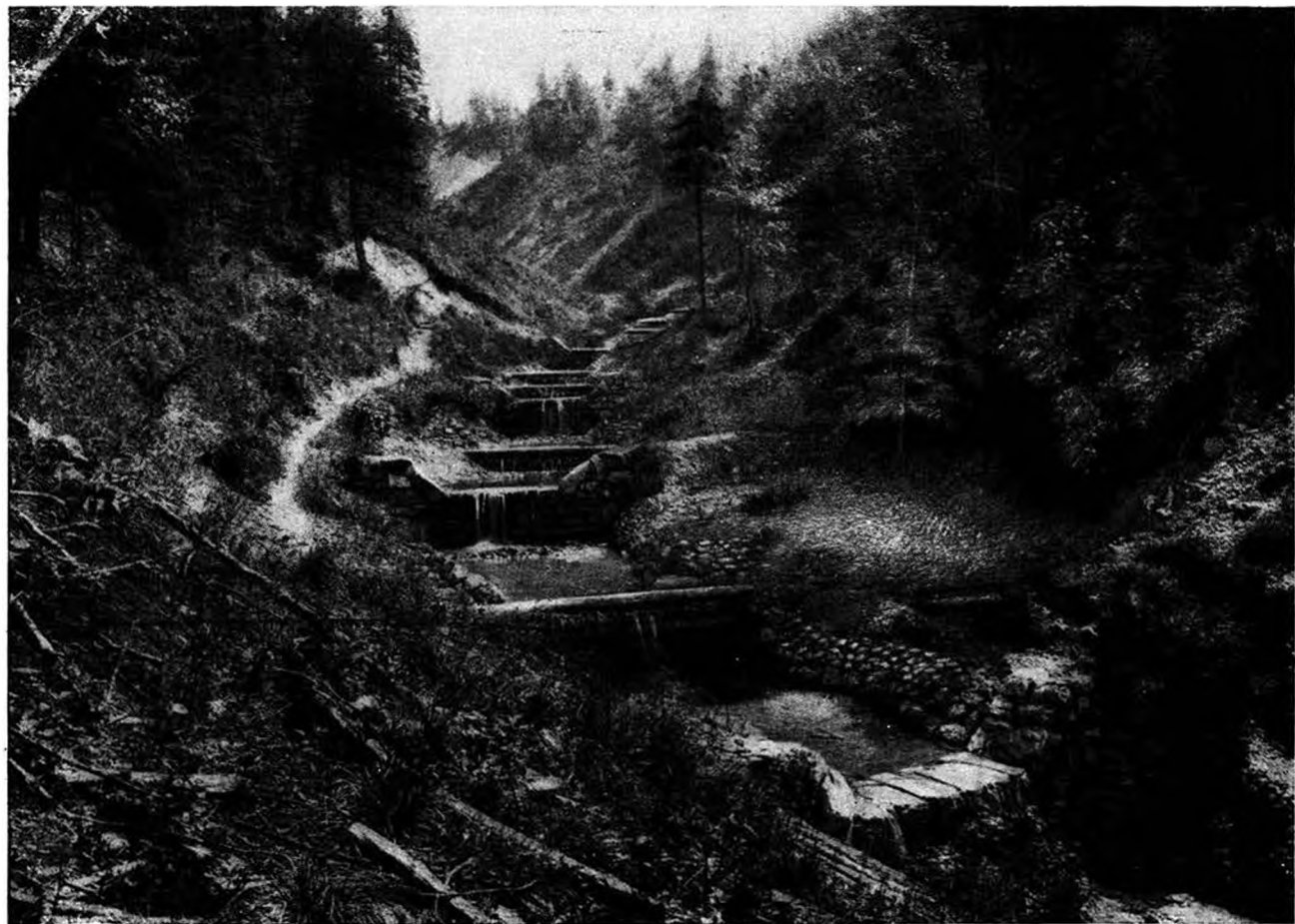
Пороги для регулирования горного потока (к стр. 362)
