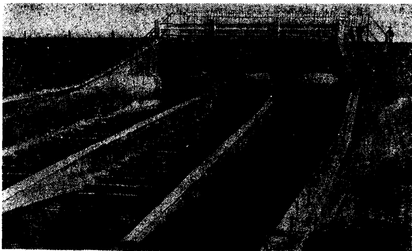
Рис. 20. Перегораживающее сооружение, совмещенное с быстотоком.
