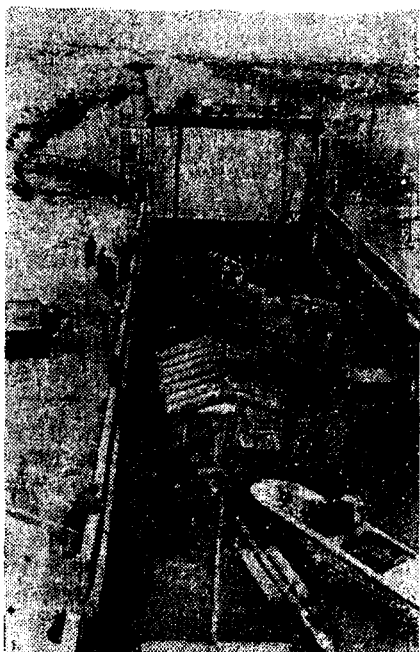
Рис. 11. Судоходный шлюз на Каракумском канале.
