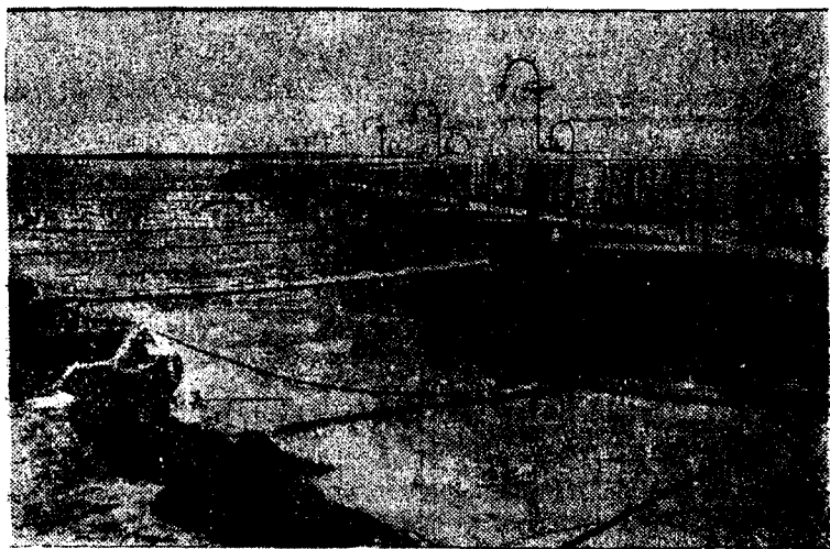
Рис. 14. Струенаправляющая система, установленная перед входом в Каракумский канал.
