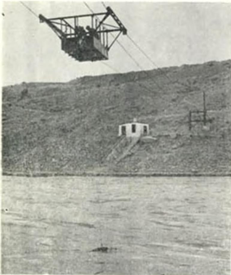
Измерение расхода воды с гидрометрической люльки.
