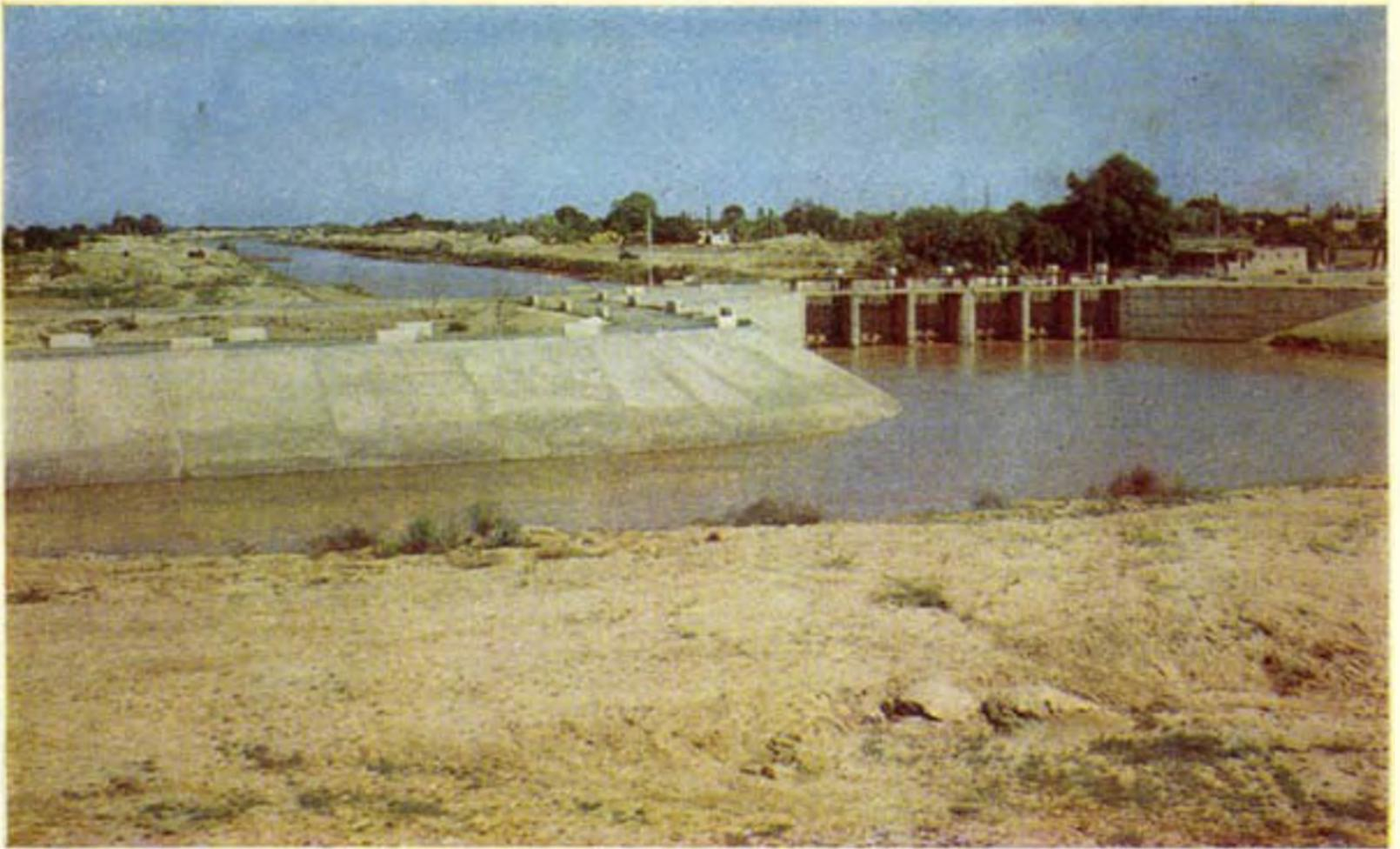
Перегораживающее сооружение на Тюймукском подпитывающем канале. Хорезм.
