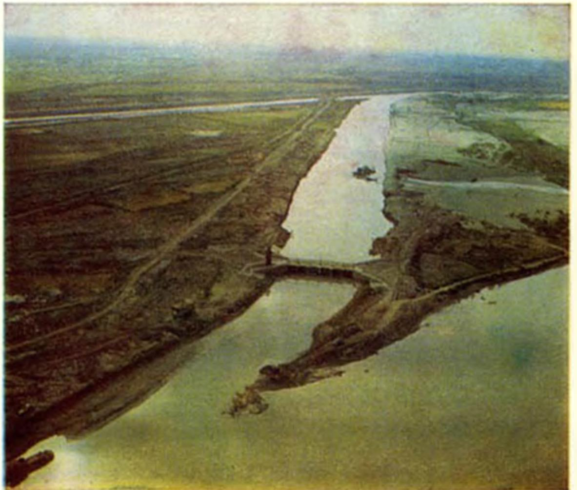
Головное сооружение Тюмюнского подпитывающего канала. На заднем плане канал от Тюмюнской плотины.
