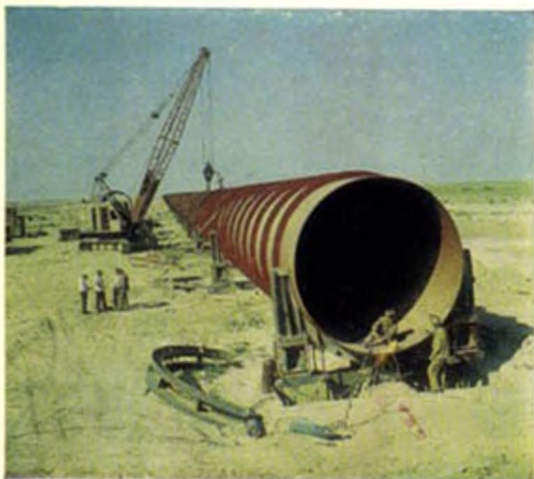
Водоприемник Джизакской насосной станции на Южногодностепском канале им. А. А. Саркисова.
