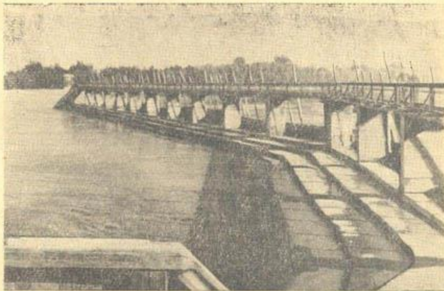
Рис. 14. Нижний бьеф Куйганьярской плотины в 1940 г. до пуска.
