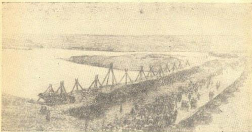
Рис. 38. Перекрытие в 1944 г. Сырдарьи на Фархалстрое.
