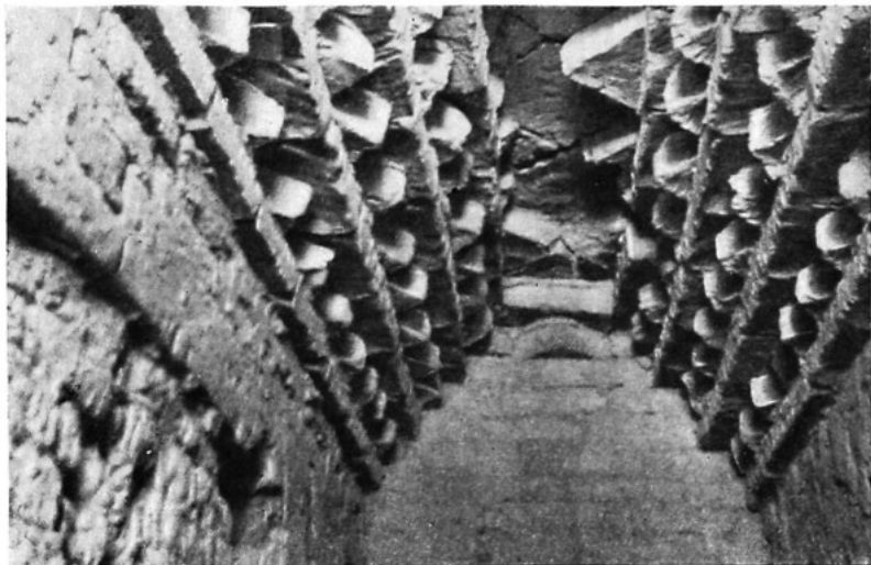
Харам-кёшк. Деталь перекрытия коридора.
