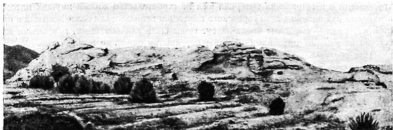
Новая Ниса. Часть крепостных стен.
