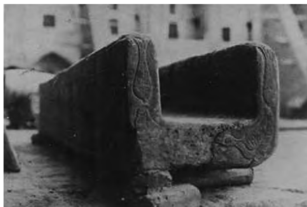
12. Водослив хауза Рашид в Бухаре. Общий вид
