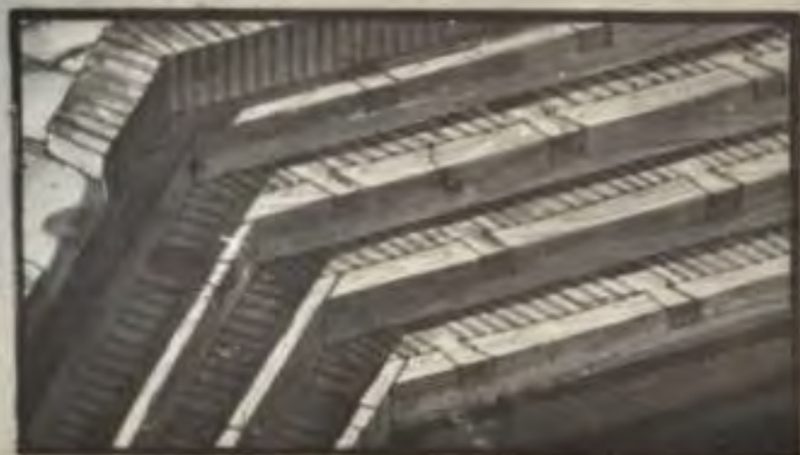
КОНСТРУКЦИЯ САМАРКАНДСКОГО ХАУЗА ИЗ ДЕРЕВА И КИРПИЧА
