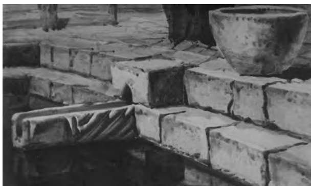
9. Водослив хауза в Бахауддине
