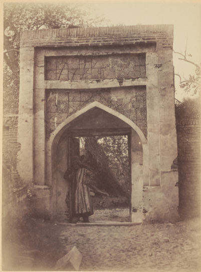
48. Порталъ входа на могилу Магзуми-Агзамъ .
