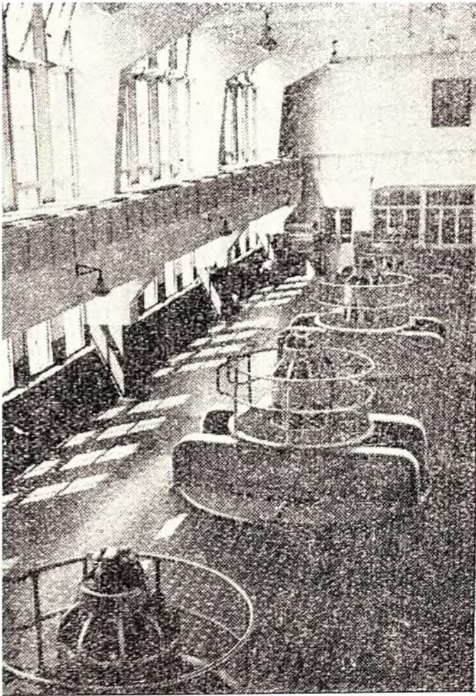
*Машинный зал одной из автоматизированных гидроэлектростанций Орджоникидзевского каскада.*
