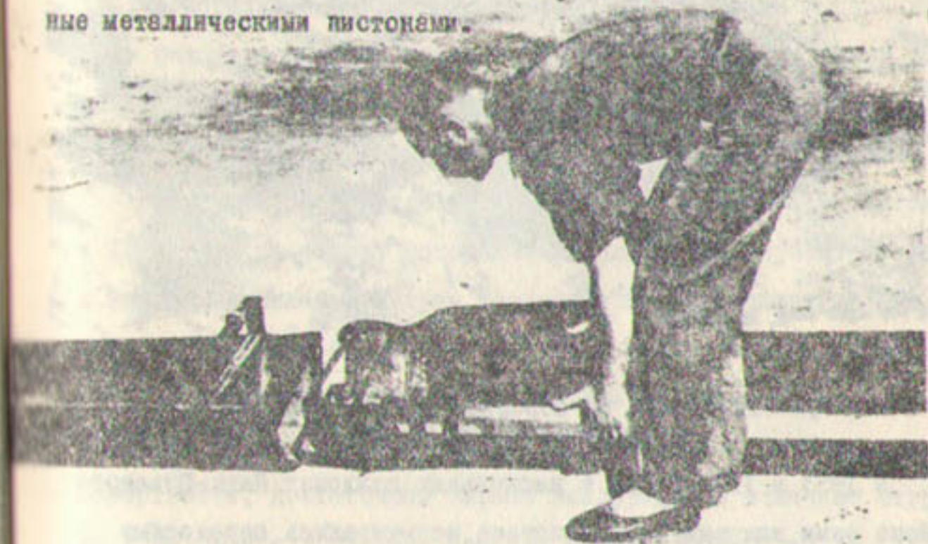
рис. 10. Соединение звеньев брезентового лотка
