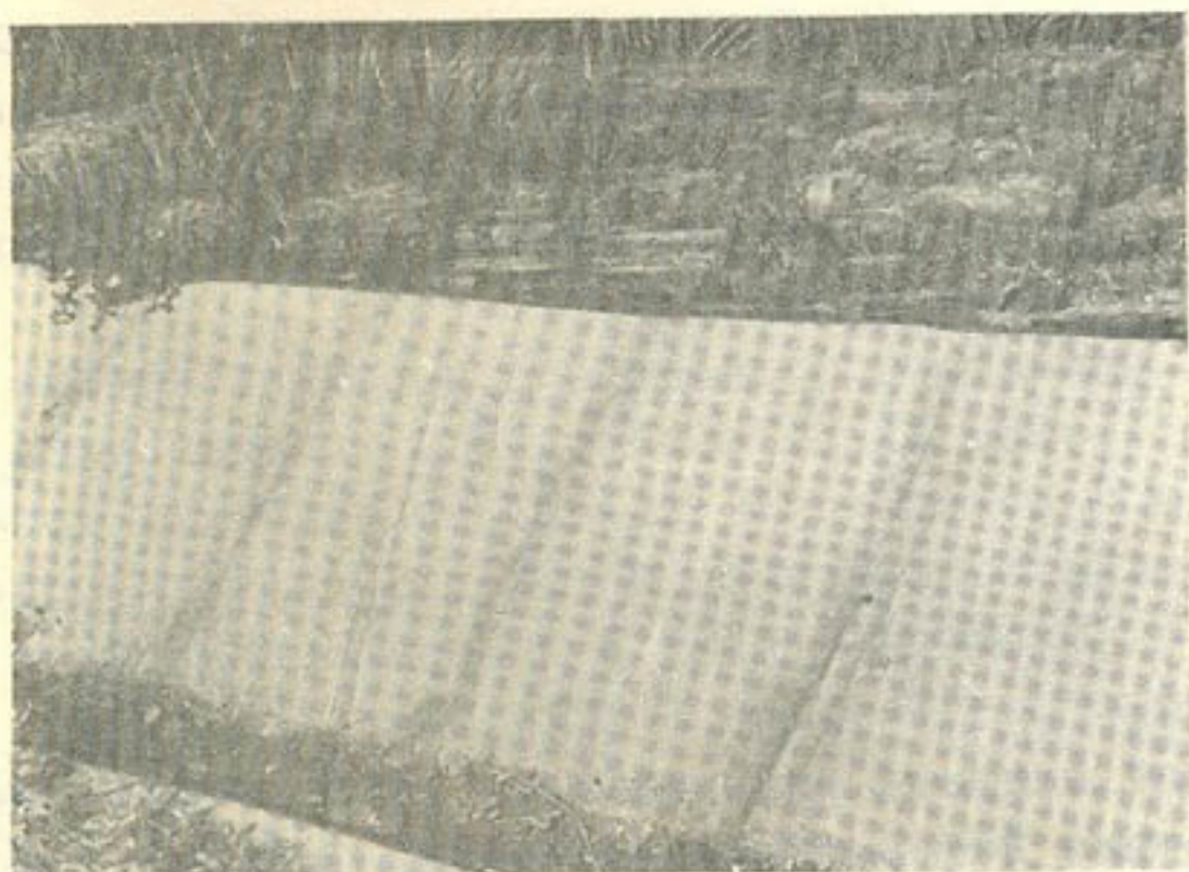
Рис.36. Канал 1-х-8-3. Вид облицовки из плит
