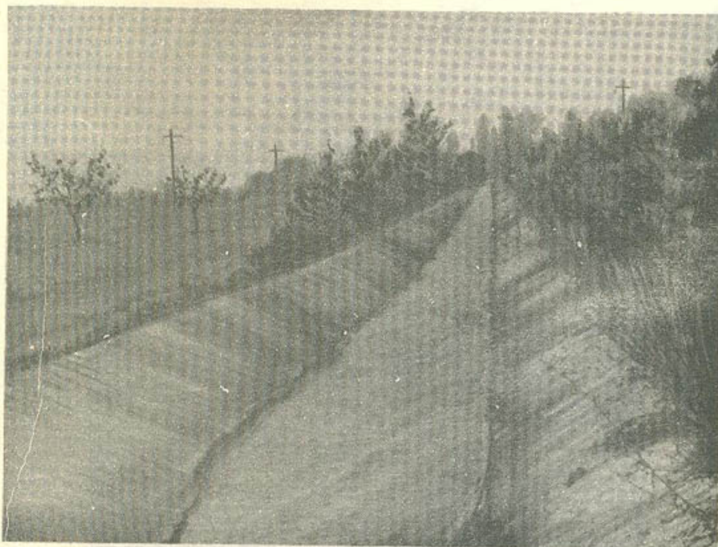
Рис.29. Канал МАК. Монолитная облицовка
