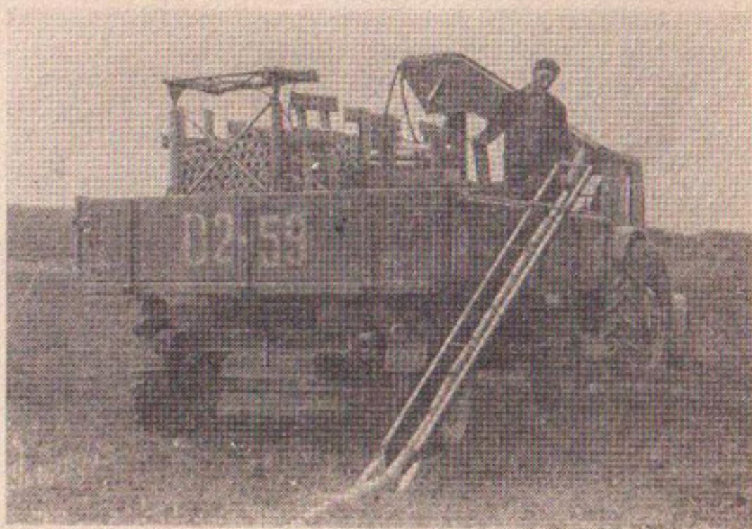
Р и с. 24. Развозка керамических труб вдоль трассы с помощью наклонного желоба
