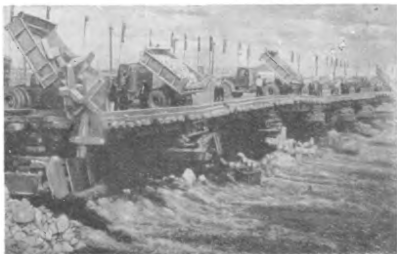
Рис. 34. Фото каркасной наброски Горьковгэсстроя.
