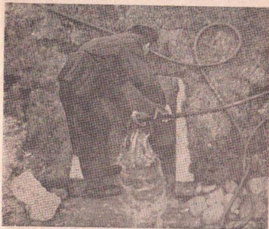
Рис. 20. Очистка дрен на опытном участке «Слоусть».
