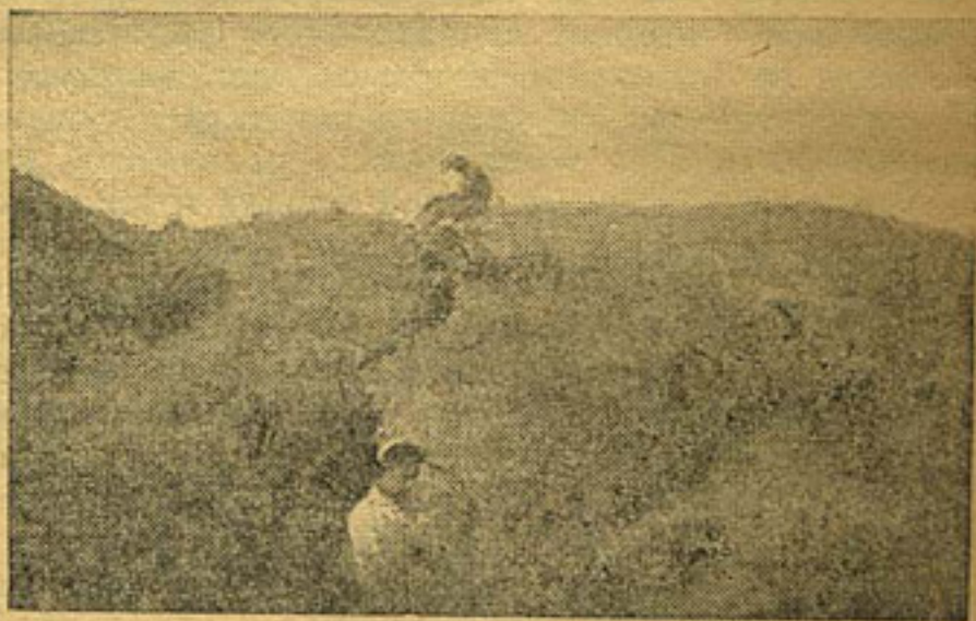
Рис. 2. Трещина оседания на канале Старый Джун
