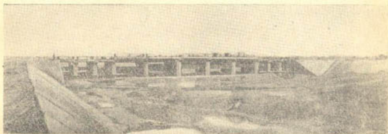
Рис. 46. Тешикташская плотина на Карадарье до монтажа затворов.
