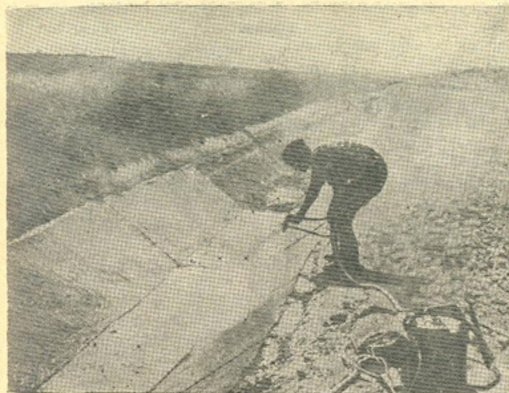
Рис. 30. Механизированное набрызгивание пленкообразующего покрытия.
