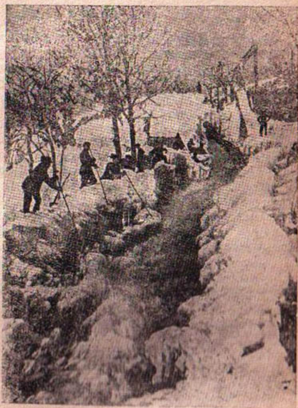
Рис. 38. Пропуск шуги и льда по быстротоку.
