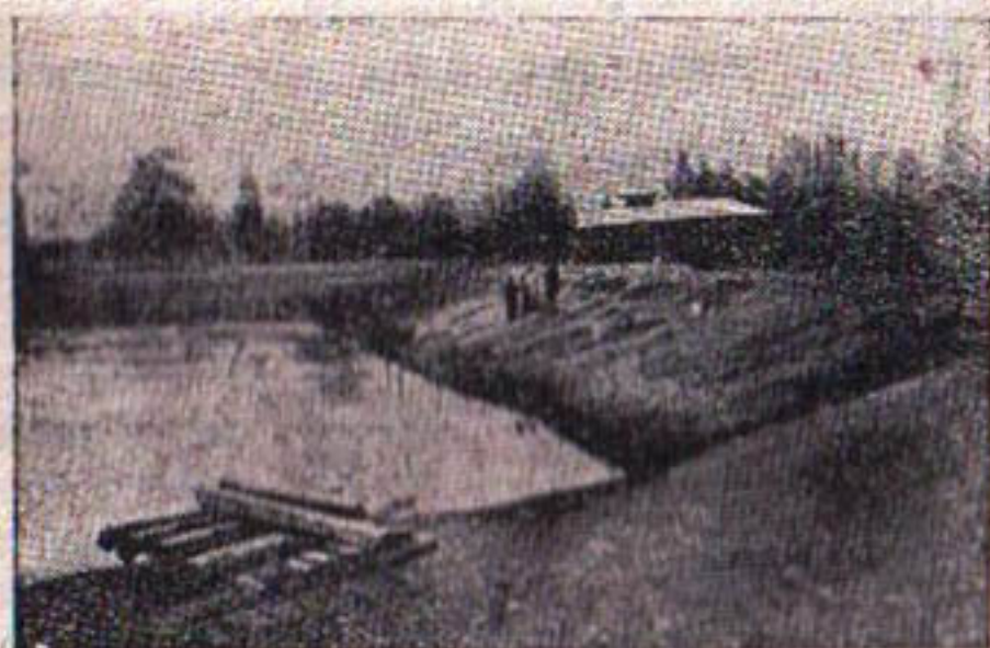
Рис. 10. Земляная плотина (вид со стороны верхнего бьефа).
