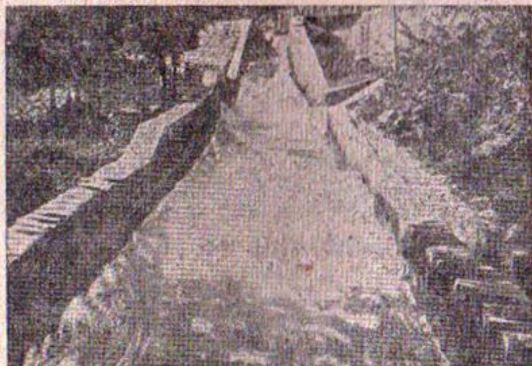
Рис. 12. Быстроток: вид сверху вниз.
