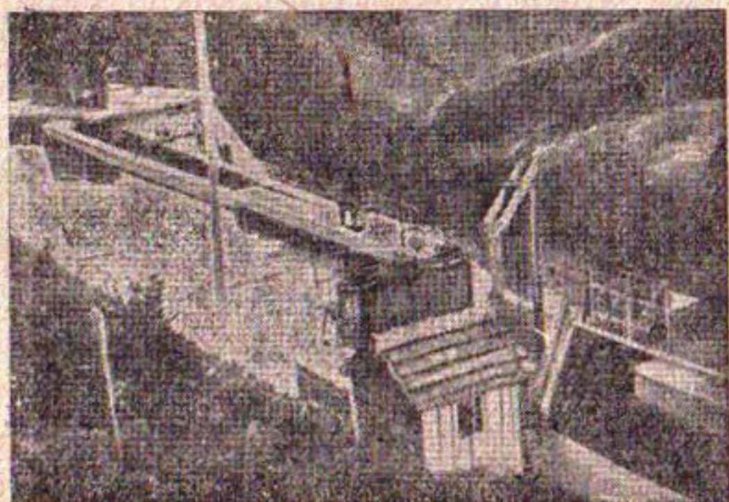
Рис. 4. Напорный и отстойный бассейн.
