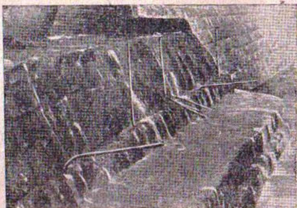
Рис. 13. Конечная часть быстротока (быстроток не работает).
