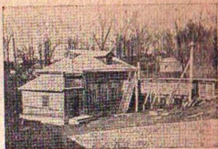
Рис. 3. Вид на гидростанцию.
