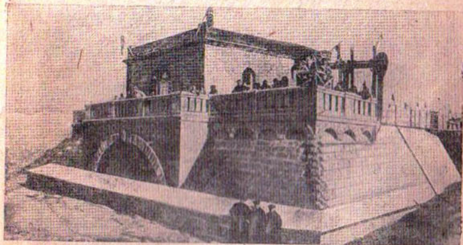
Рис. 9. Вид на бассейн и напорные камеры снизу.
