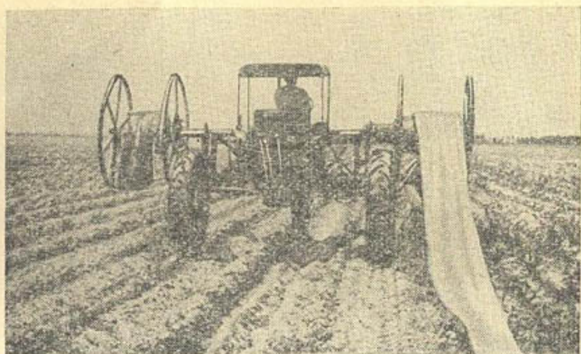
Рис. 4. Укладка и сборка гибких трубопроводов с помощью навесного намоточного устройства с двумя катушками.
