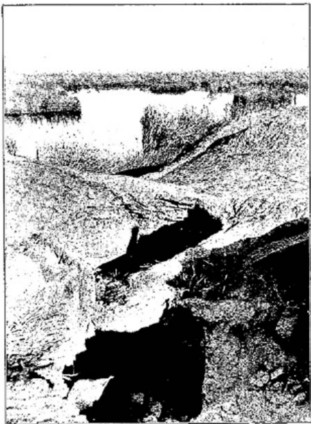
Разрушение берегов сбросными водами.
