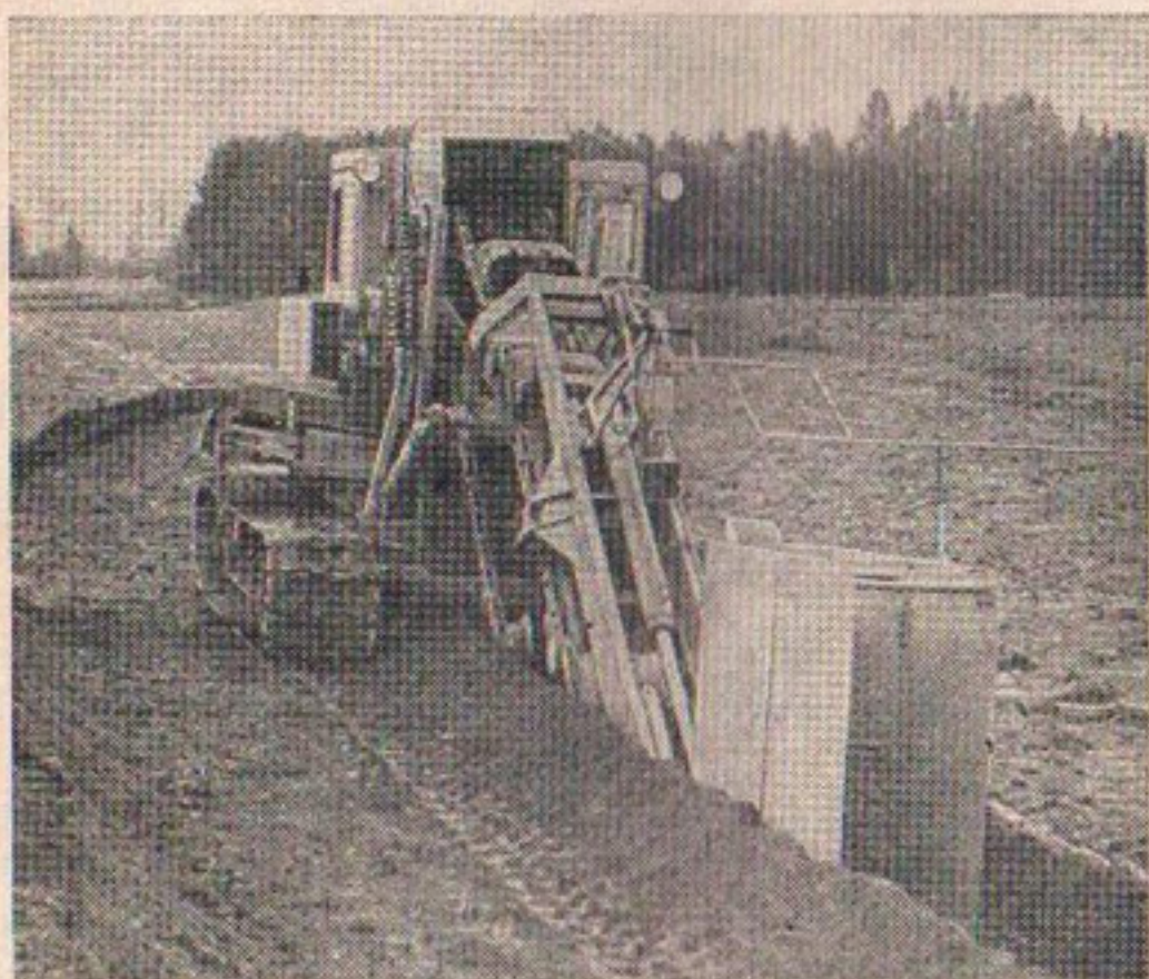
Рис. 26. Экскаватор ЭТЦ-202 в работе.
