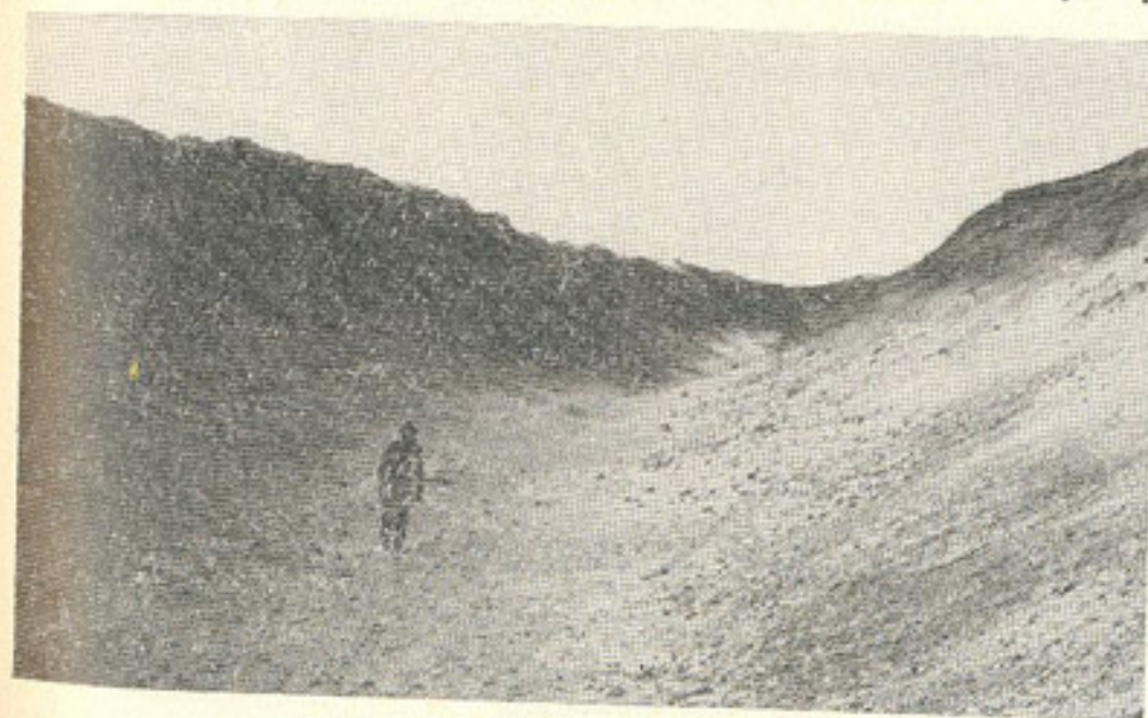
Рис. 27 Участок Каракумского канала, полученный взрывным способом.
