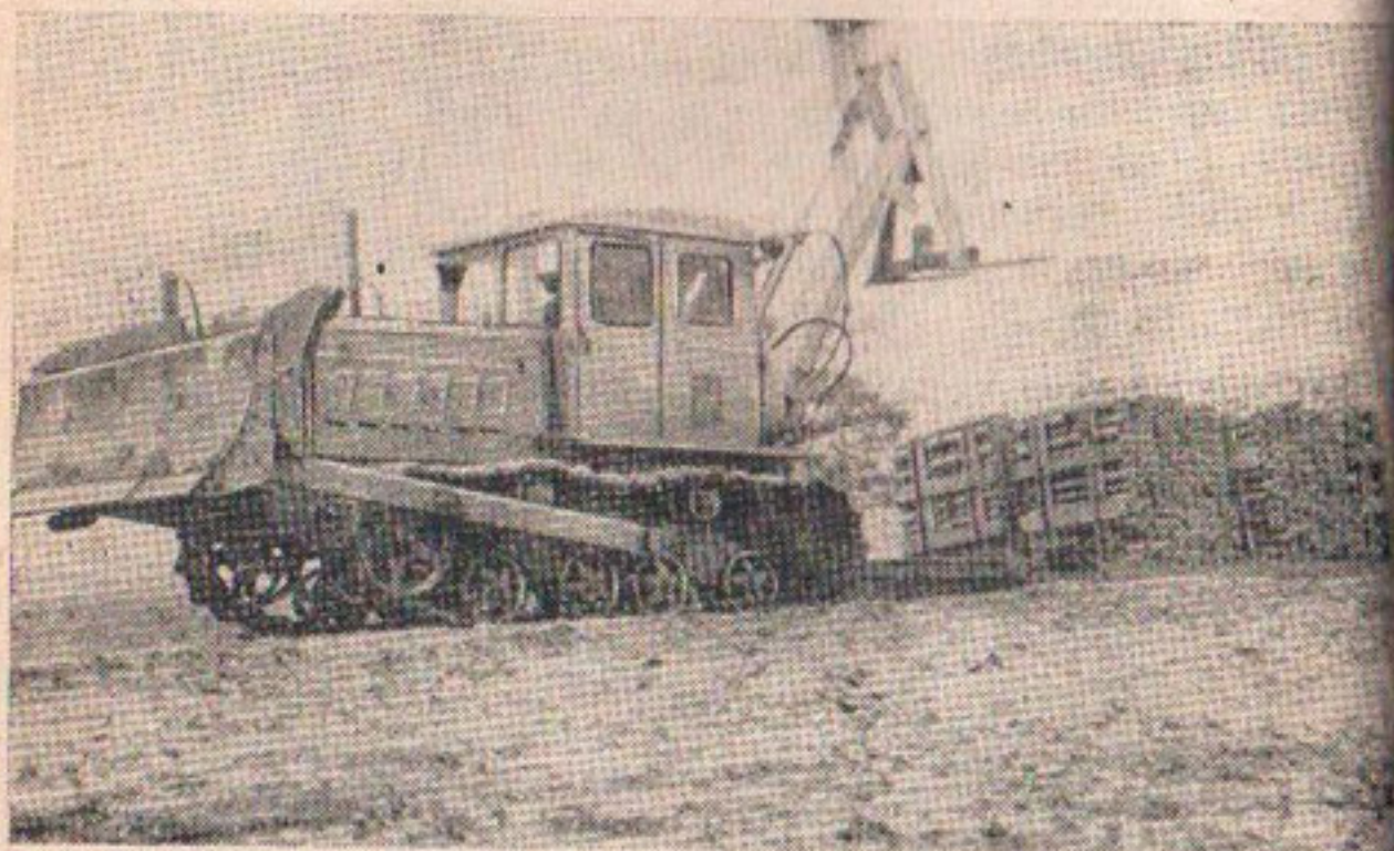
Рис. 21. Развозка труб в контейнерах по трассам.
