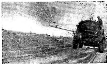
Рис 32. Нанесение мелкорантов с помощью прицепного битумовоза БКР-1, оборудованного шланговым и дугообразным распылителем
