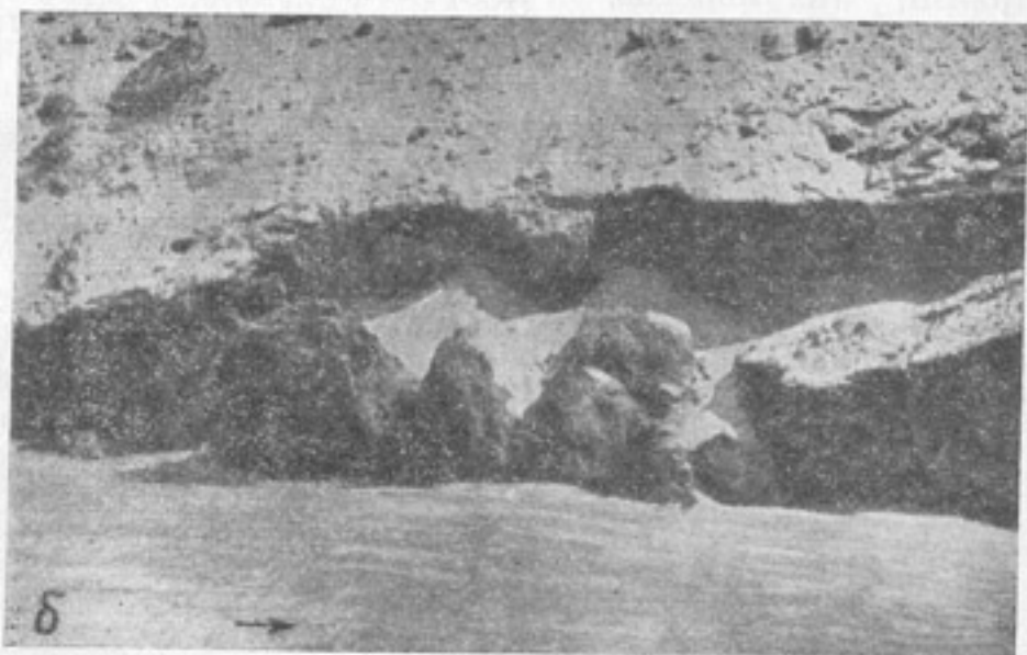
Рис. 1. Местный размыв (дейгиш) берегов Каракумского канала меандрирования (б), и образование осередков, приводящее к общему нх несвязными 1 — воронка дейгиша;
