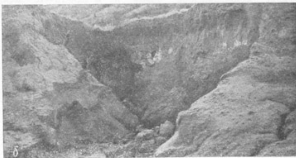
Рис. 25. Виды деформаций берегов а — оползни; б — промоины; в — отмель,
