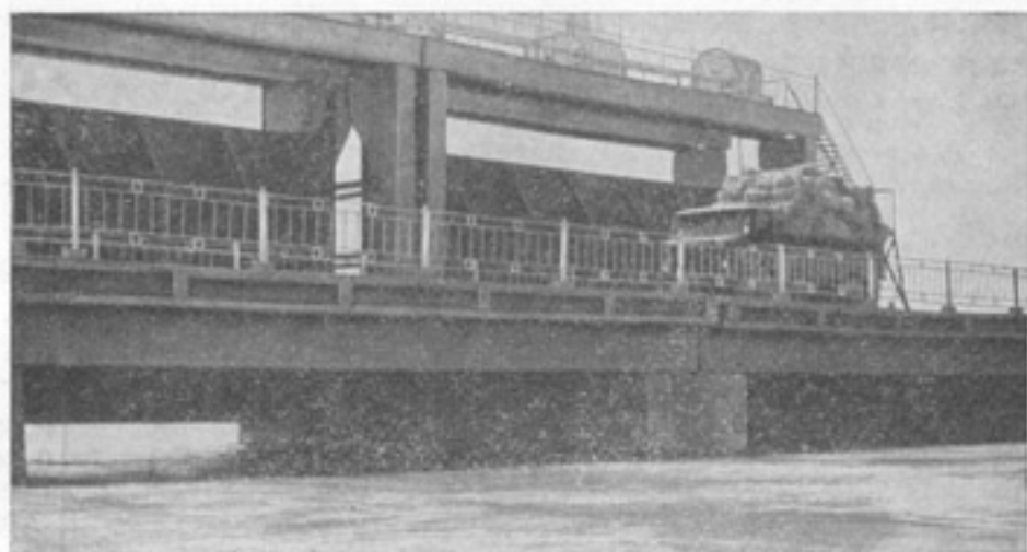
Рис. 27. Перегораживающее сооружение на Каракумском канале.
