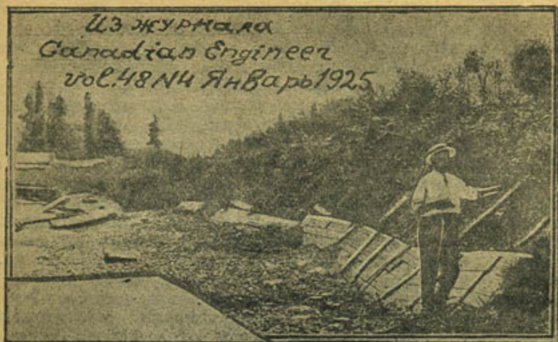
Рис. 2 Временная защита подошвы берега
