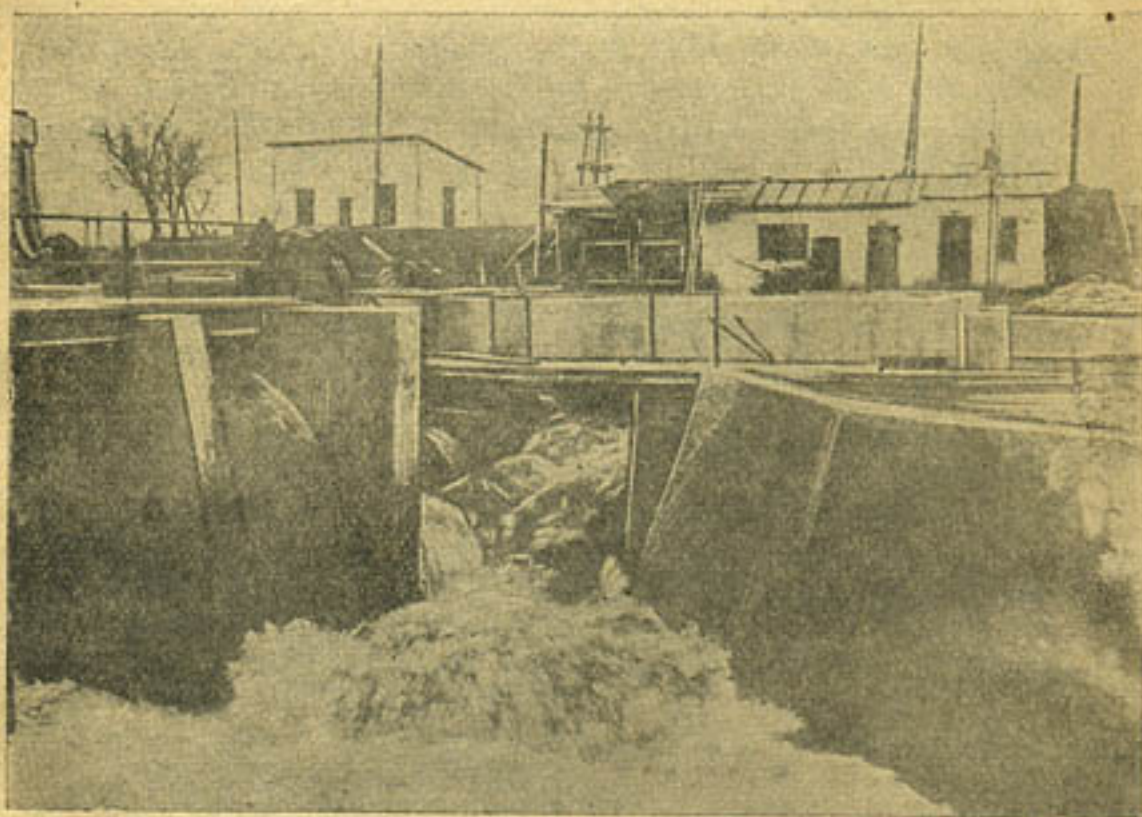
Рис. 7. Выход из лотка в перепад
