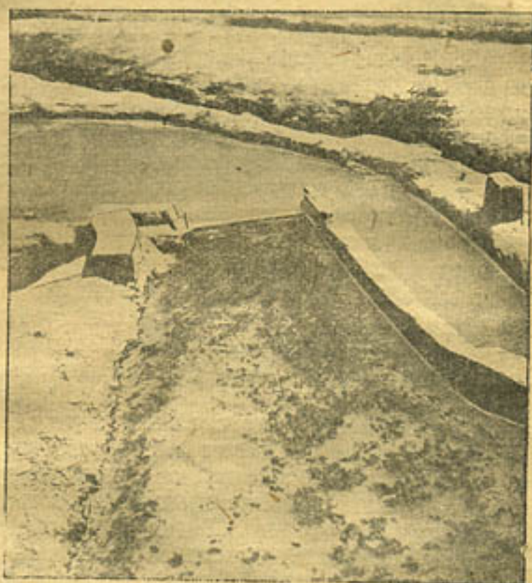
Рис. 5. Сброс шуги лотком (модель).
