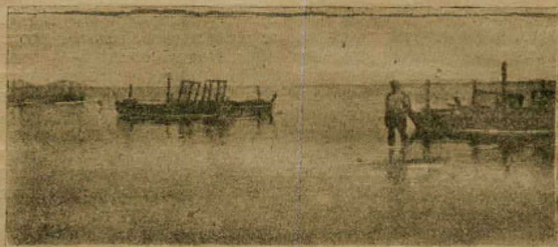
Рис. 5 Общий вид сетчатой установки заплотителя с образовавшимися за ней отложениями, где ранее была глубина 3-4 м.
