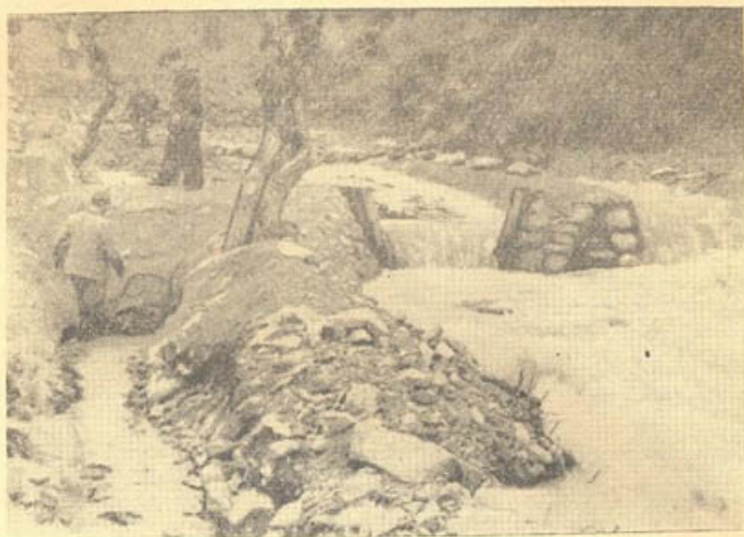
Рис. 4. Вид с нижнего бьефа на бассейн по измерению воды и наносов.
