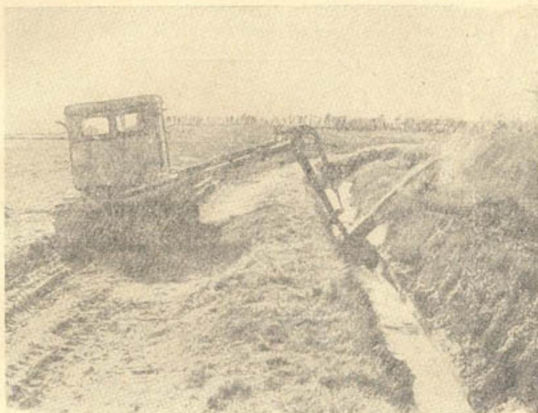
Рис. 1. Каналоочиститель Д-342А в работе.
