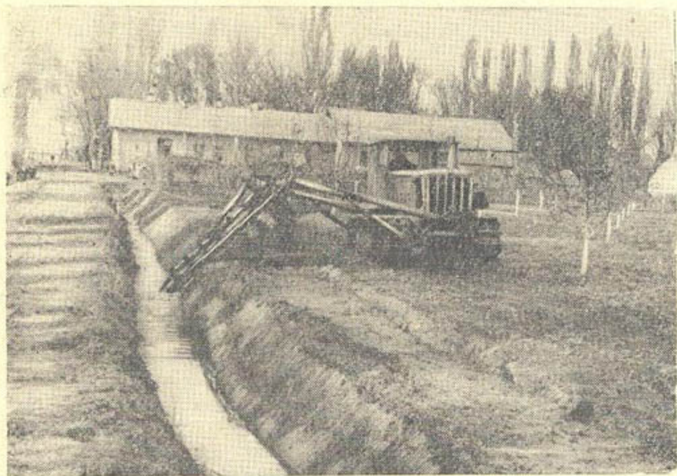
Рис. 3. Каналоочиститель Д-342А со скребковым оборудованием в работе.
