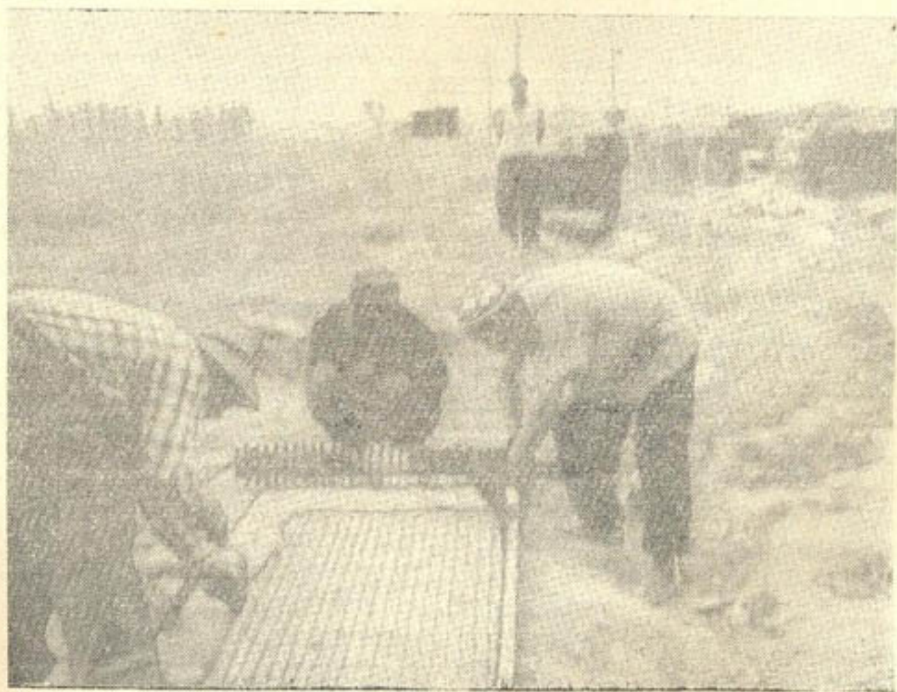
Рис. 4. Нарезка лент при помощи дискового ножа.
