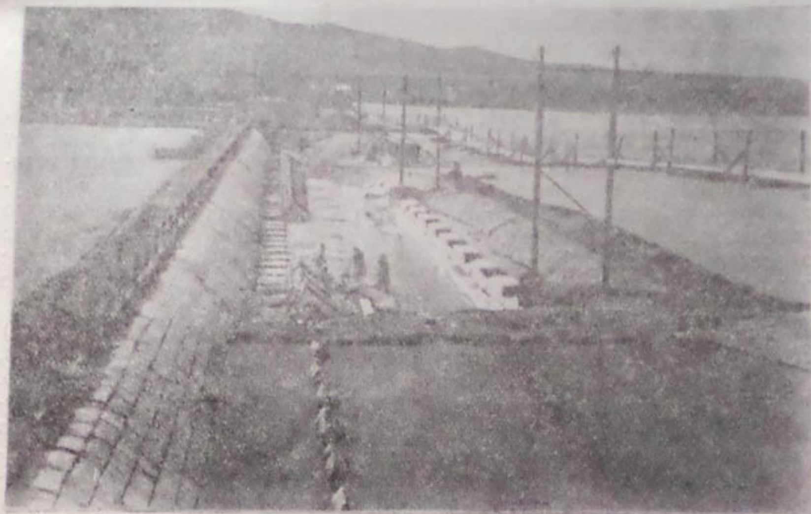
Рис. 3. Вид нижнего бьефа водосливной плотины в период ремонта весной 1951 г.
