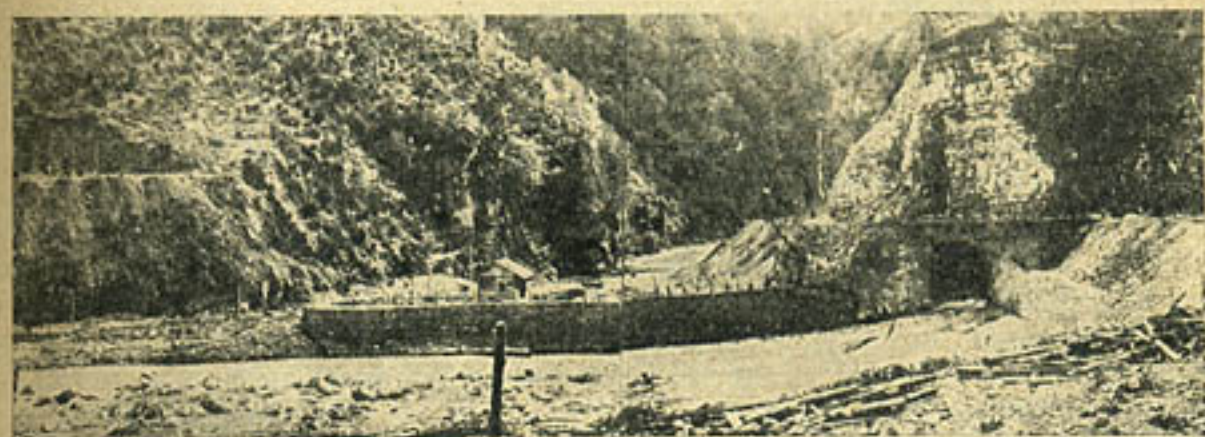
Рис. 3. Общий вид работ по постройке Аджарис-Цхальской гидро-станции. Видны габионы, сделан отвод реки в донный туннель.
