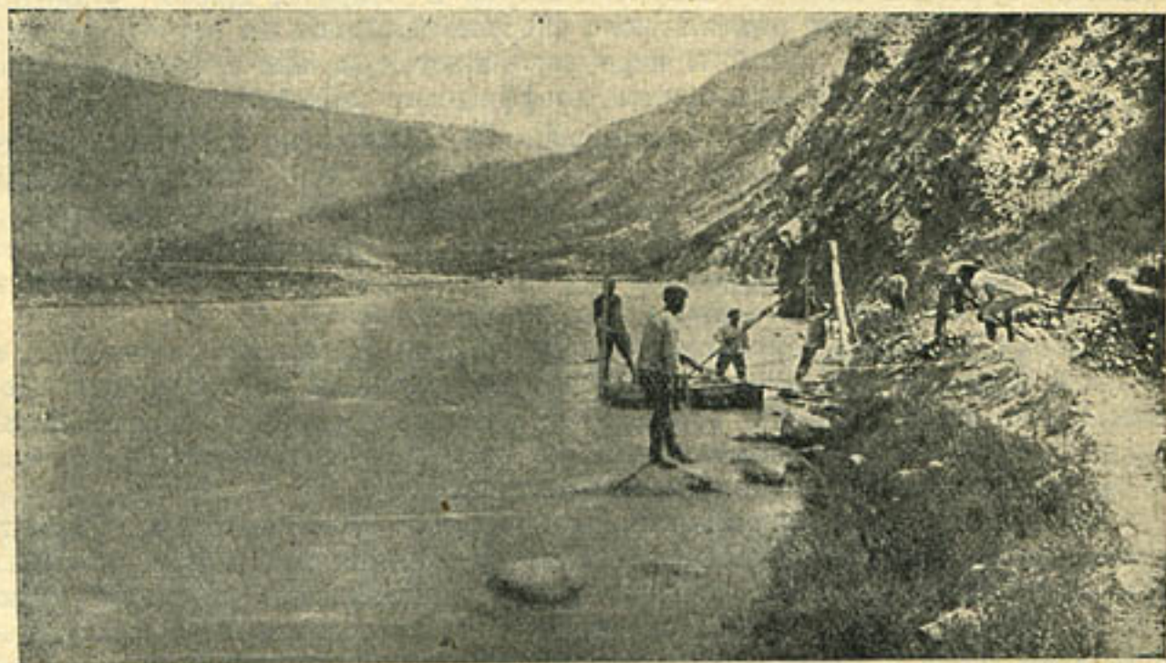
Рис. 14. Устройство гидрометрического поста на р. Дюшамбинке
