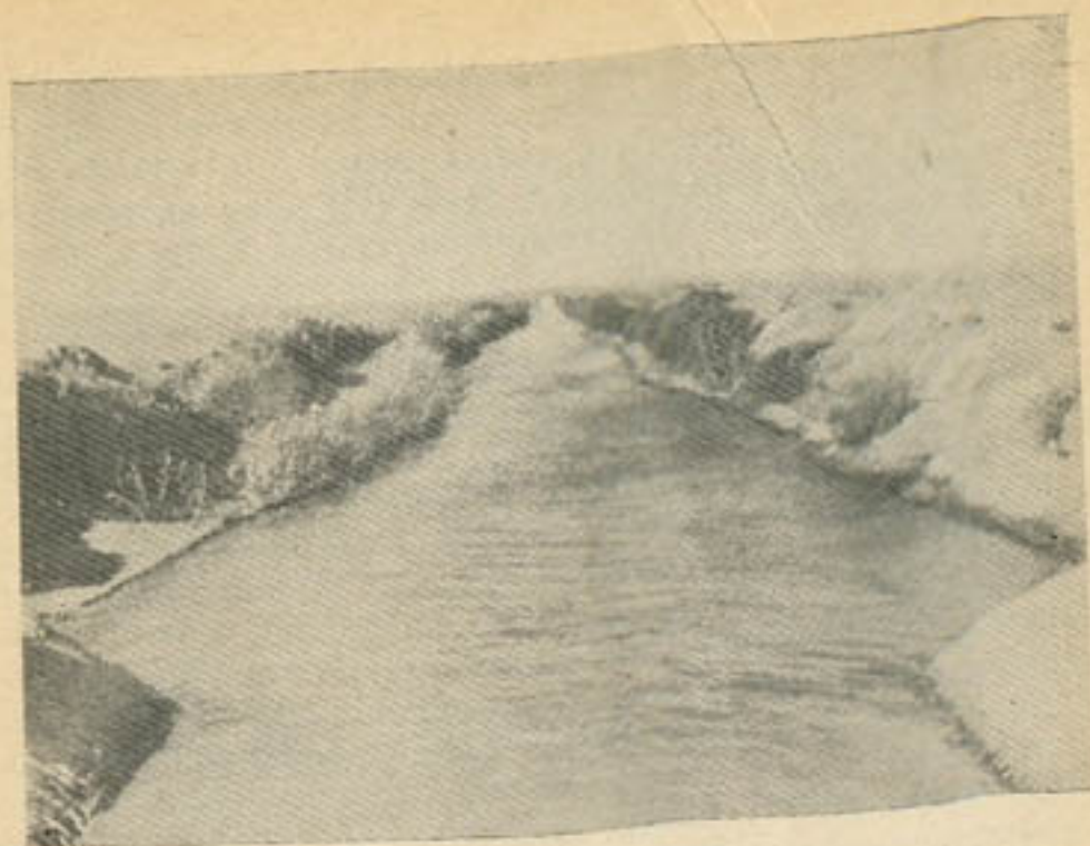
Рис. 22. Канал им. Москвы на опустыненных землях.
