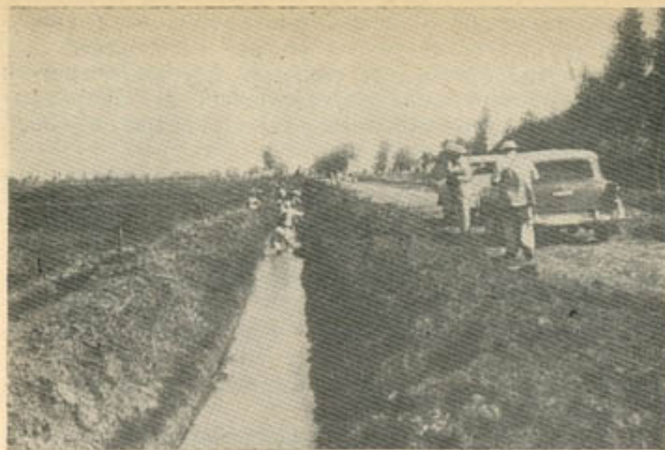
Рис. 17. Открытая дрена на землях, подверженных засолению, в дельте Нила. Почвогрунты хорошо держат откосы.
