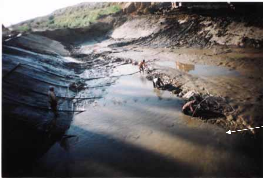
Рис. 3 - Испытание перфорированных труб (стрелкой указана струя в конце 1 витка трубы)
