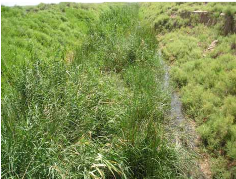
Рис. 1 - Общий вид коллектора с плотно (свыше 300 шт/м 2 , тростник, рогоз) заросшим дном и откосами.
