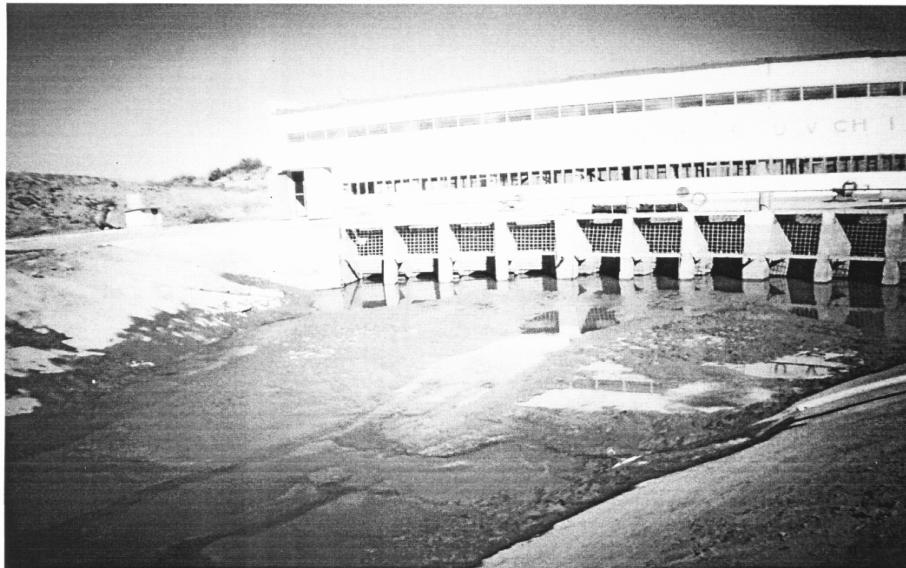
Рис. 1 - Вид аванкамеры насосной станции М - II – 2 с отложениями наносов
