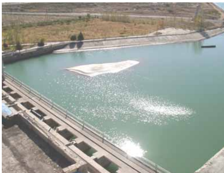
Рис.1 Аванкамера насосной станции № 7 КМК
